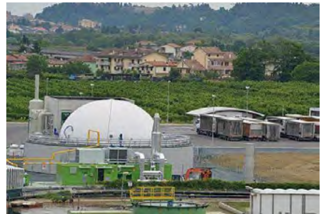
Biogestore anaerobico di Avi. Coop S.c.a.
