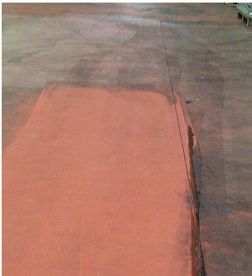
Fase 4. Rimozione Morchia
