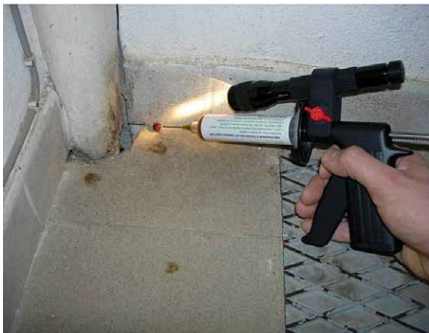
Figura 3 – Pistola dosatrice utilizzata per l'applicazione di esche gel in gocce.
