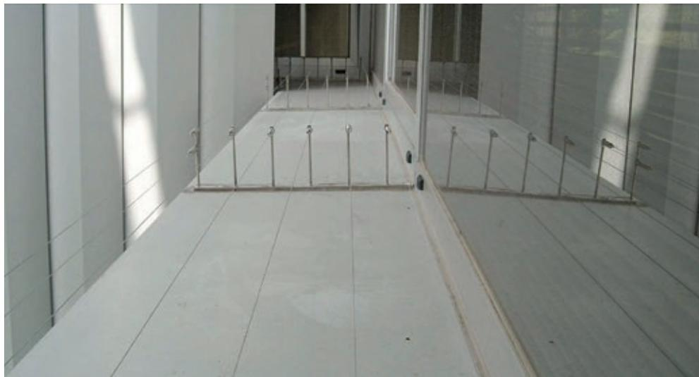
Fig. 3: esempio di installazione di filo ballerino.
