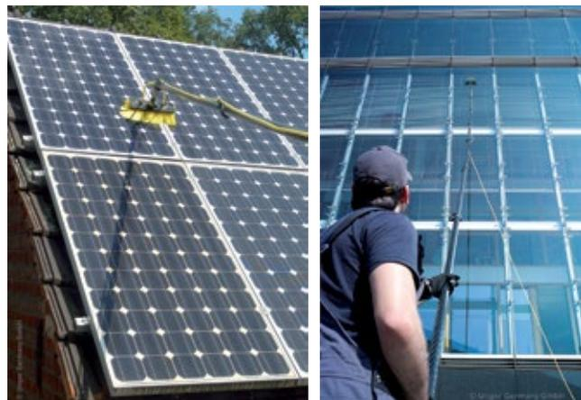
poiché non serve più asciugare con un tergitvetro, e di lavorare in sicurezza ed economia evitando l'uso delle piattaforme. Infatti abbinando ai filtri a resine o ad osmosi inversa un'asta idrica nLite, è possibile lavare fino a 20 metri di altezza con i piedi a terra. Ed in più è un sistema di lavaggio ecologico, che permette di evitare l'uso ed il riversamento nell'ambiente di prodotti chimici.
