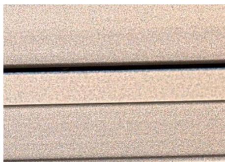
SUPERFICIE TRATTATA CON ACID POWER
