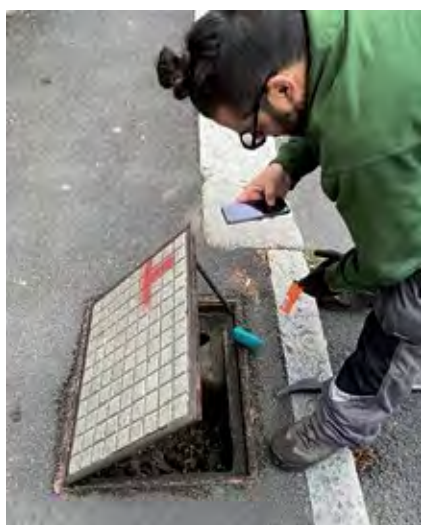
Fig.3 - Posizionamento e controllo delle esche rodenticida in una bocca di lupo infestata da ratti.
