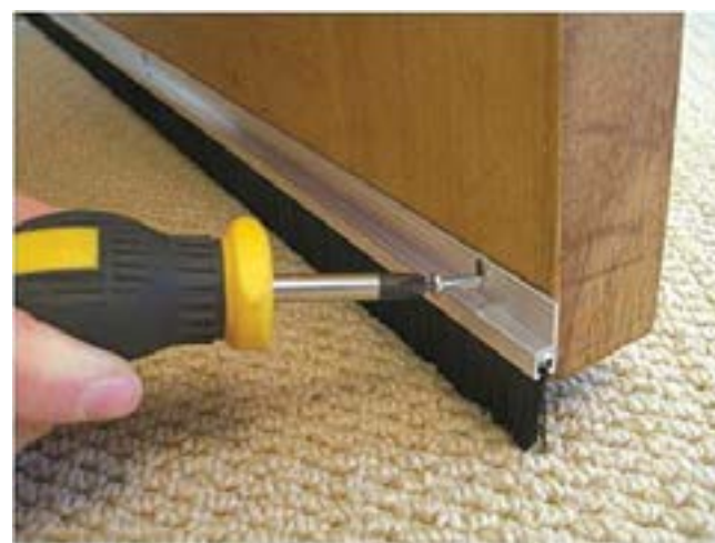
Fig 4 Installazione di spazzole per la prevenire delle intrusioni di infestanti.
