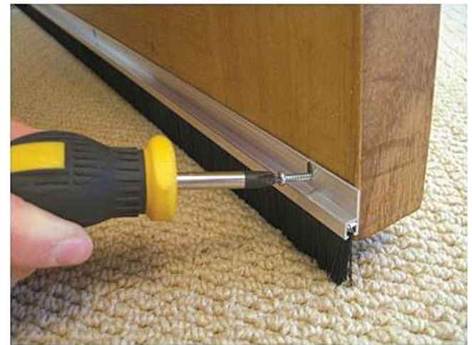
Fig 4 Installazione di spazzole per la prevenzione delle intrusioni di infestanti.
