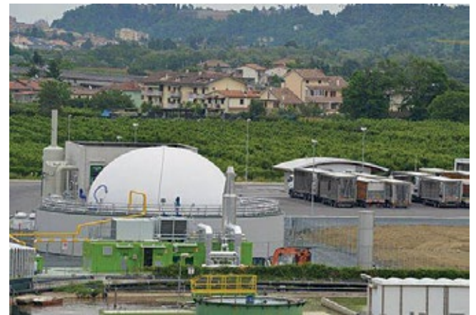
Biogestore anaerobico di Avi. Coop S.c.a.
